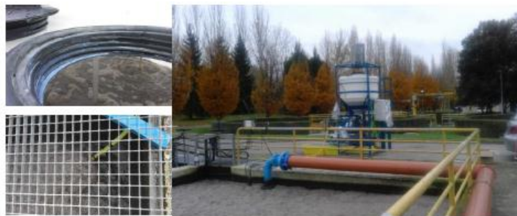
Llenado desde arqueta en la salida de las balsas de nitrificación
